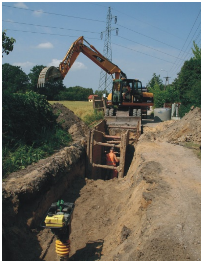
Budowa kanalizacji Nowe Osiny, ul. Żwirowa, 2014 rok
