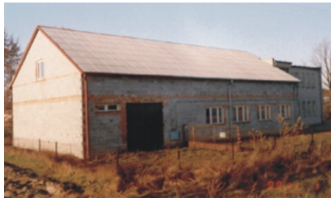
Remiza OSP w Zamieniu wraz z pomieszczeniami SUW, około 2000 rok
