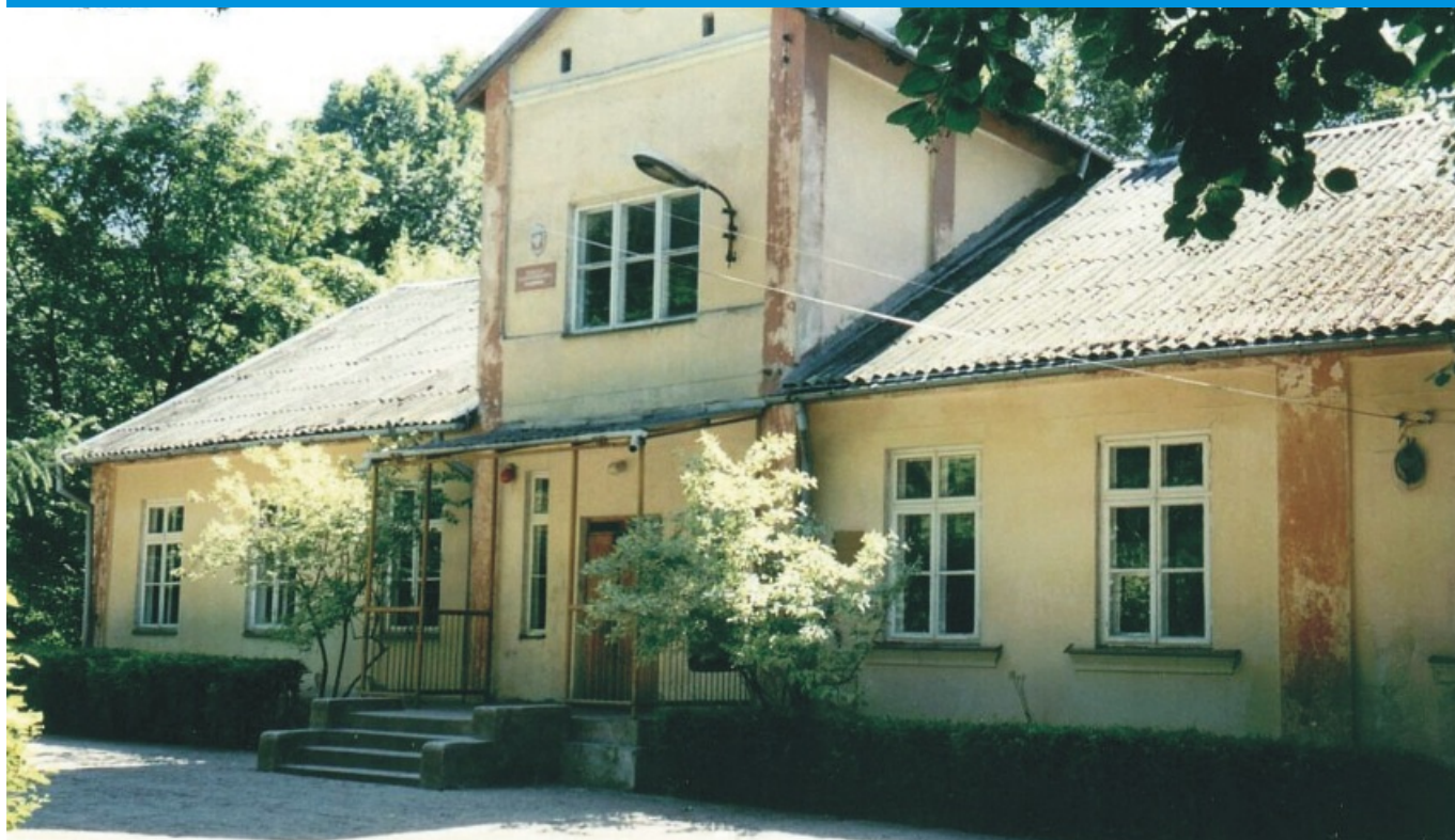
Budynek dawnej szkoły
