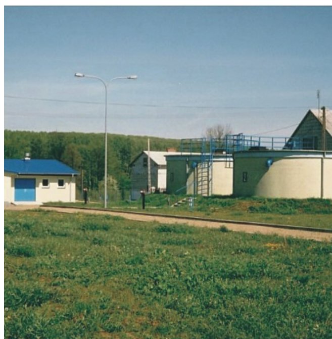
Stacje uzdatniania wody w Janowie, 2007 rok
