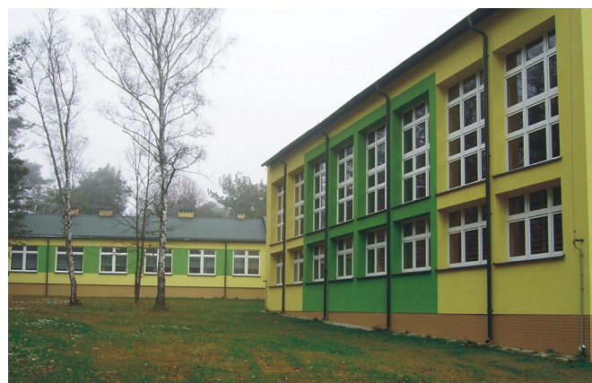
Szkoła Podstawowa w Mariance po zakończeniu rozbudowy, 2006 rok
