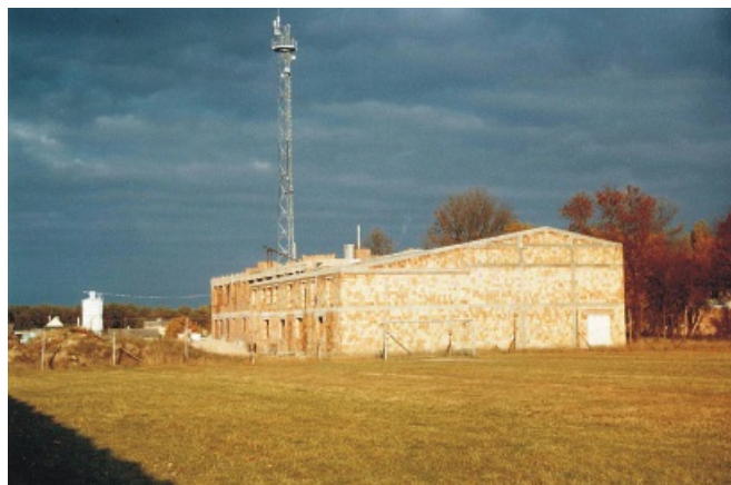
Szkoła Podstawowa w Zamieniu w trakcie budowy, 2006 rok
