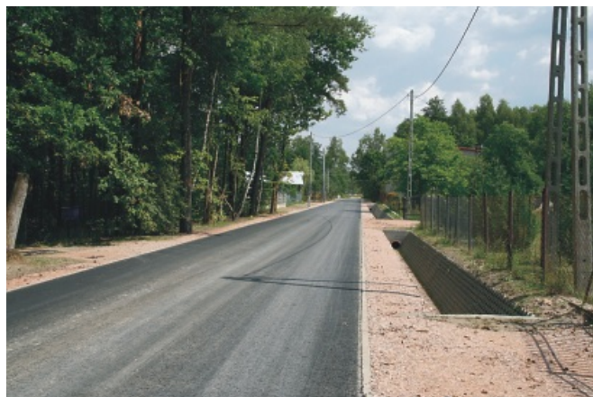
Nowa droga z odwodnieniem w Zakolu
