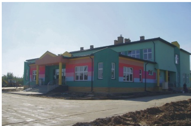
Szkoła Podstawowa w Stojadłach tuż przed zakończeniem budowy, 2006 rok
