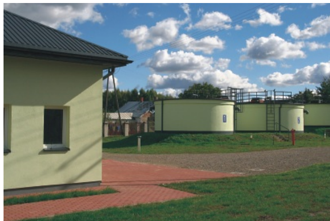
Stacja uzdatniania wody
