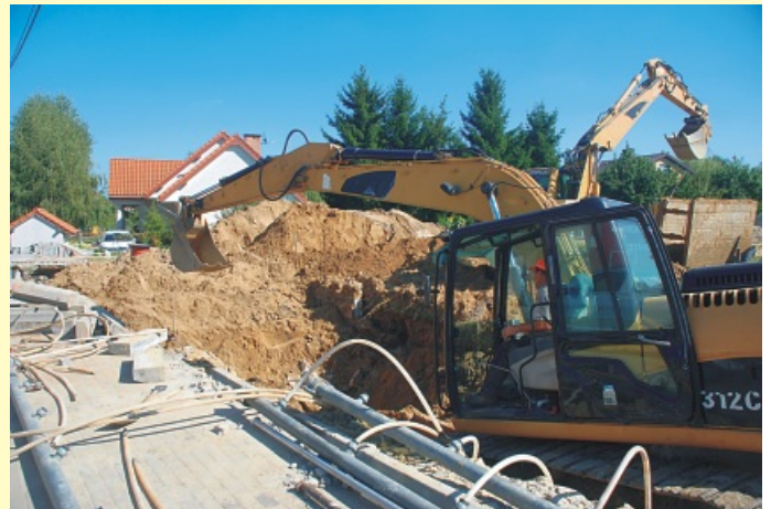
Janów. Głębokie wykopy przy budowie przepompowni ścieków.
