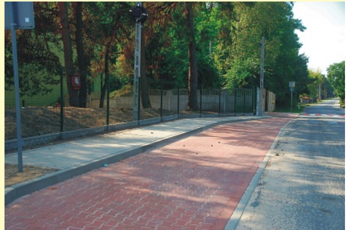
Zatoka autobusowa przy ulicy Wspólnej w Mariance, przeznaczona dla autobusów szkolnych. Inwestycja zakończona.
