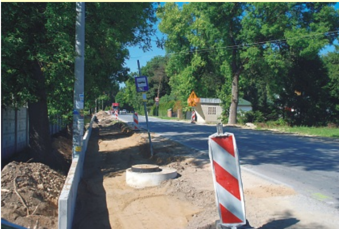
Budowa kanału kanalizacji deszczowej pod planowaną ścieżką rowerową Huta Mińska - Mikanów.
