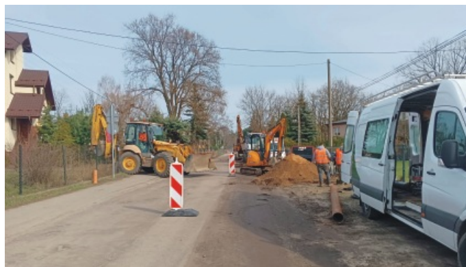
Budowa kanalizacji sanitarnej Marianka, ul. Wspólna
