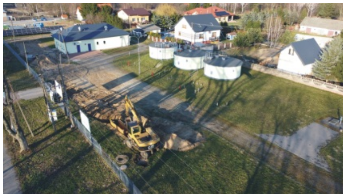
Budowa kanalizacji sanitarnej Janów, ul. Wspólna
