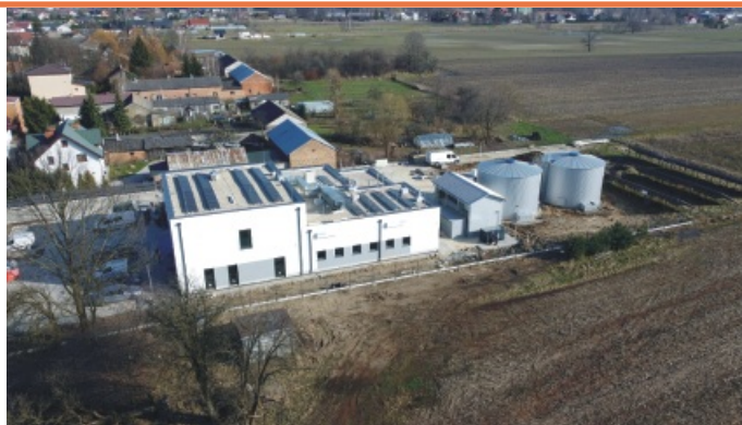
Stacja Uzdatniania Wody w Królewcu
