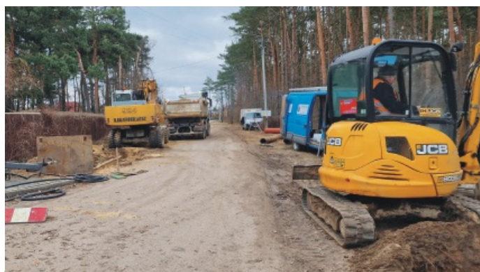
Budowa kanalizacji sanitarnej Huta Mińska, ul. Leśna
