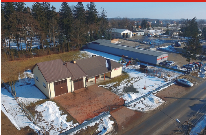
Budynki strażnicy OSP w Starej Niedziałce
